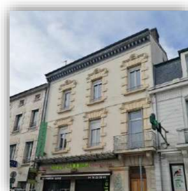
Façade de l'immeuble de Caluire et Cuire
